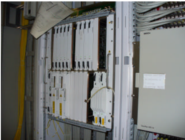
In diesem vollklimatisierten Technikraum sind Gestellreihen mit Übertragungstechnischen Geräten aufgebaut.
