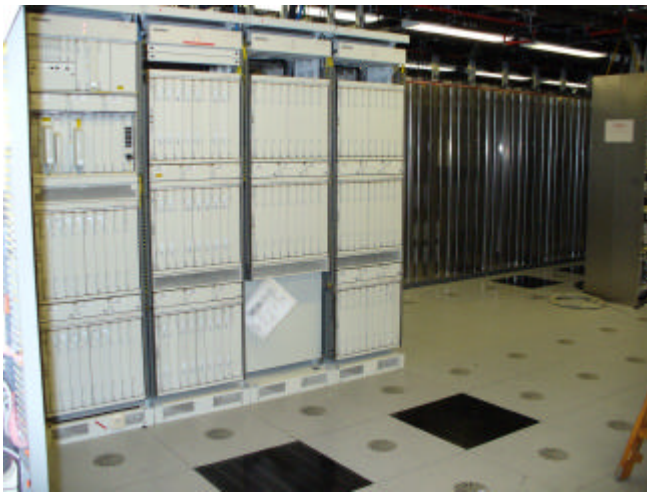
In diesem vollklimatisierten Technikraum sind Gestellreihen mit Übertragungstechnischen Geräten aufgebaut.
