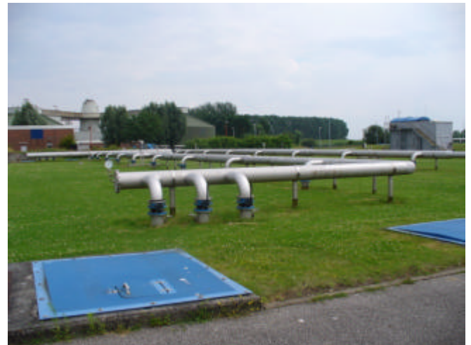
Mit dem Gasspürgerät immer voran, Frau Dr. Ahlert-Bassermann, LIn QM beim AZV. Auffällig wie viele der Klärbecken unterirdisch angeordnet sind. Durch die Rohre wird Sauerstoff eingebracht um den biologischen Abbauprozess zu beschleunigen.
